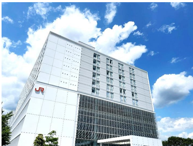
【写真】 JR 東海総合研修センター施設外観
