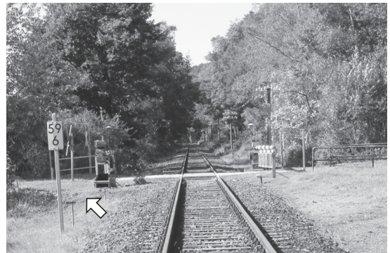
写真12 ワイヤ式の踏切（線路左の矢印部、前後方向にワイヤがある）
