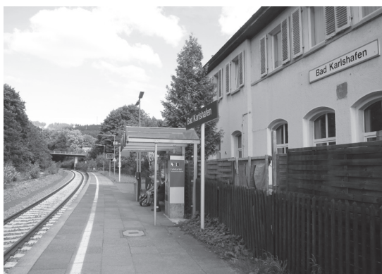
写真 16 一般住宅となった後も駅名表示が残る旧駅舎
