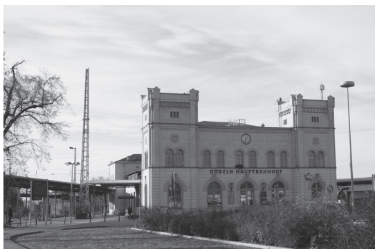
写真1 1868年に都市郊外で開業した中央駅
