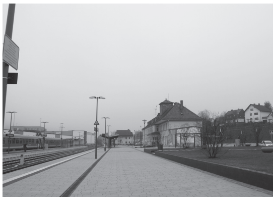
写真10 線路を撤去し面積を拡大した駅ホーム
