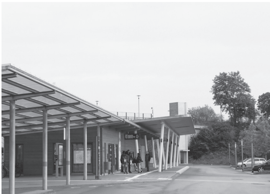
写真8 大きな屋根を備えた駅舎
