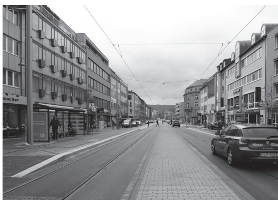
写真 17 車道を大幅に削減し歩道を拡幅した通り (カッセル／上：2011 年，下：2016 年)
