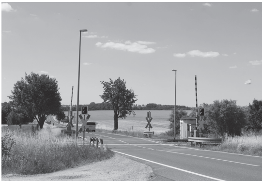
写真2 廃止区間にある Eckartsberga 駅前の踏切。周辺に人家はない。
