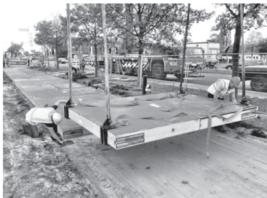
写真2 SolaRoad 設置工事時 出典：www.solaroad.nl/
