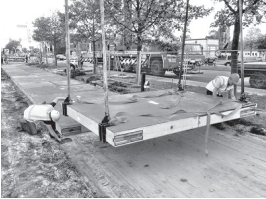
写真2 SolaRoad 設置工事時 出典：www.solaroad.nl/
